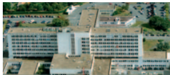
Strecha so štrkovým zásypom
