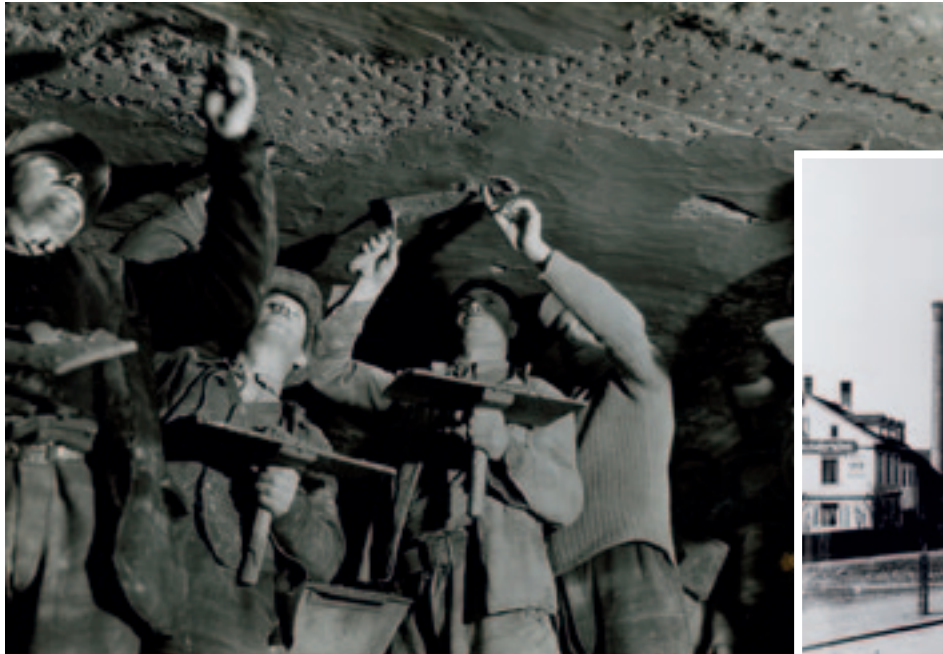
Kaspar Winkler a jeho vynález Sika (Sika-1) prísada, ktorá po pridaní do malty zvyšuje jej vodonepriepustnosť.
